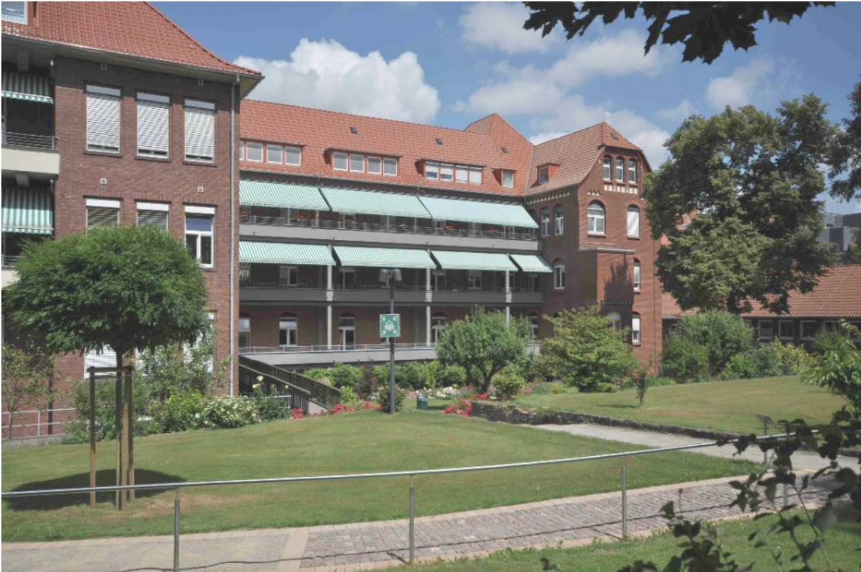
Hüttenhospital Dortmund, Hauptgebäude Am Marksbach, Gartenseite
